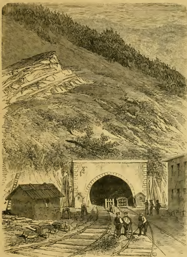
FIG. 8. — ENTRÉE DU TUNNEL DU MONT GENIS.
